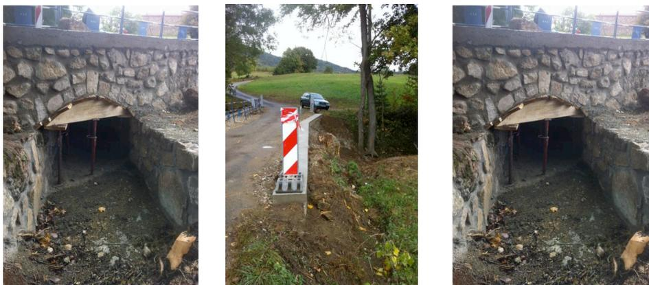
Sur le chemin de Maison Blanche, le petit pont, sérieusement endommagé, a été réhabilité par une équipe de TREMPILIN (association d'insertion) et les employés communaux qui ont remonté un mur de soutènement en pierre. Le passage pour l'eau a été remis en état. Cela nous semble assez réussi côté technique et environnemental.
